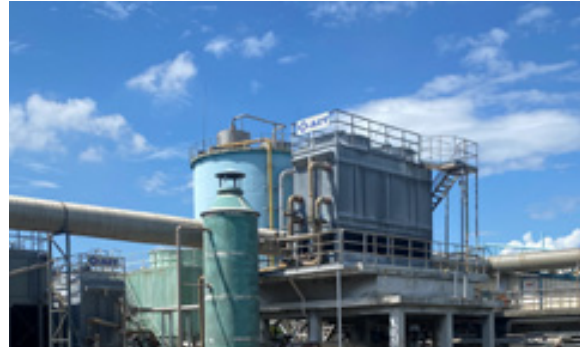
广纸集团改造后的闭式冷却塔成功解决污水异味扩散问题
