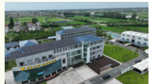
越秀租赁为越秀交通随岳南高速打造的光伏项目
