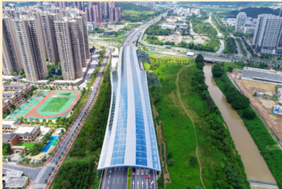
越秀交通北二环高速建设项目
